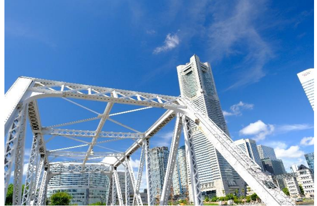
第2橋梁とランドマークタワー
